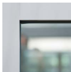
Détail du châssis : dormant-ouvrant
