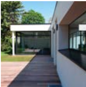
Maison individuelle - Saint-Cloud (92) Agence d'architecture : GLR Architecture - Laurent Rouxel Architectes associés : Sophie Rouxel - Manuel Serra Maître d'ouvrage : Privé Aluminier Agréé Technal : GAM Protection
