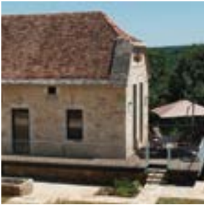
Maison individuelle - Assier (46) Agence d'architecture : Devaux Virginie Maître d'ouvrage : Privé Aluminier Agréé Technal : Miroiterie Villefrancoise
