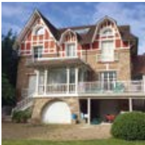
Maison individuelle - Villennes-sur-Seine (78) Agence d'architecture : Sylvie J&Co Architecture et espaces intérieurs Maître d'ouvrage : Privé Aluminier Agréé Technal : Broyez
