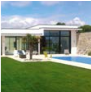
Maison individuelle - Angoulins-sur-Mer (17) Agence d'architecture : SD Architectes Maître d'ouvrage : Privé Aluminier Agréé Technal : Menuiserie Chauvet
