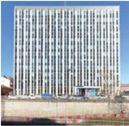
Immeuble de bureaux UIOSS Toulouse (31)
