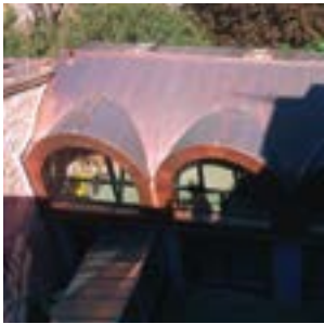
Villa Omnes - Toulouse (31) Agence d'architecture : Goulven Omnes Architecte Maître d'ouvrage : Privé Aluminier Agréé Technal : MAS
