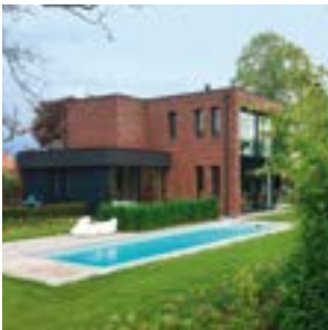
Maison individuelle - Louvil (59) Agence d'architecture : Guillaume Beunier Maître d'ouvrage : Privé Aluminier Agréé Technal : Constru
