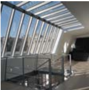
Surélévation et création d'un duplex - Paris (75) Agence d'architecture : MO Architectes Jeremie Moller Architecte DPLG Maître d'ouvrage : Privé Aluminier Agréé Technal : AMDF
