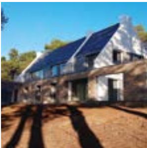
Maison individuelle - Baden (56) Agence d'architecture : Atome Maître d'ouvrage : Privé Aluminier Agréé Technal : Baies-Alu
