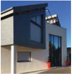
Maison individuelle - Damery (51) Agence d'architecture : Laure Calvoz architecte DPLG Maître d'ouvrage : Privé Aluminier Agréé Technal : Tapprest Menuiserie
