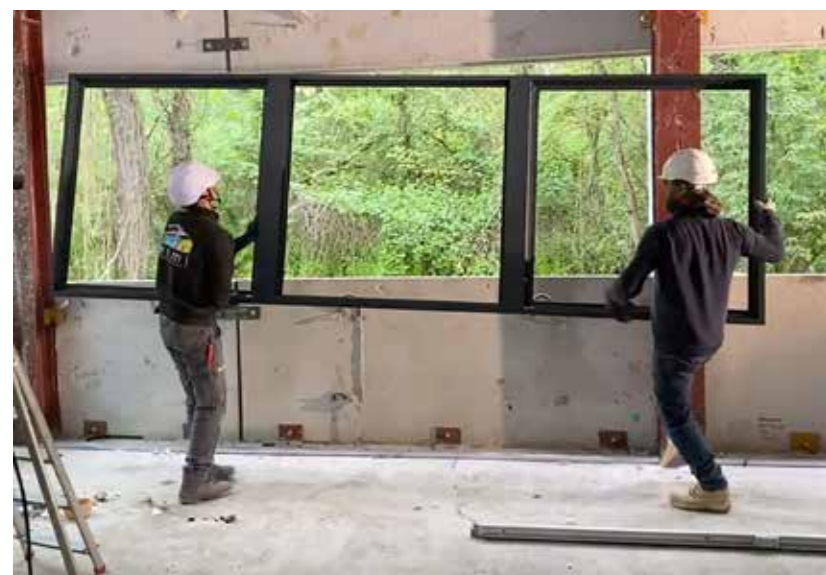
Repose des menuiseries WICONA sur le chantier Ginger
