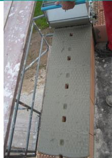
Vereinfacht das Aufbringen einer deckelnden und durchgehend geschlossenen Mörtelbahn sowohl bei gefüllten wie auch bei ungefüllten Mauerziegeln. Die Mörtelrolle MR ist speziell geeignet für das Auftragen von **Dünnbettmörtel auf Planziegel**.
