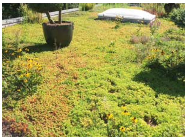
Végétalisation extensive avec couche de rétention d'eau
