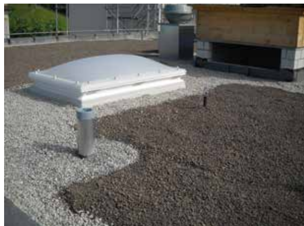
Mise en œuvre de l'aménagement de la toiture selon les normes
