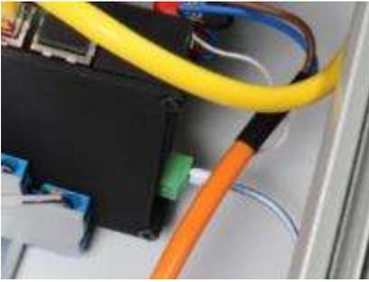
Der Steckverbinder hat eine weiße (5 V) und eine schwarze (GND) Ader. Wenn das Modul auf der DIN-Schiene montiert ist, ist die weiße (5 V) zur Unterseite des Gehäuses hin ausgerichtet.
