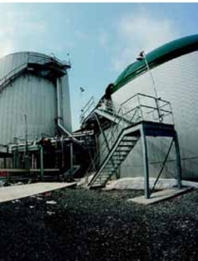
Digestori (levo) i BTA pulper za otpad (desno). Varen, Kanada.
