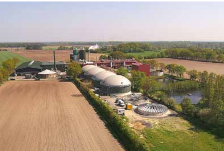
Postrojenje za biogas na bazi mulja nastalog preradom krompira, sa sopstvenim postrojenjem za tretman otpadnih voda.
