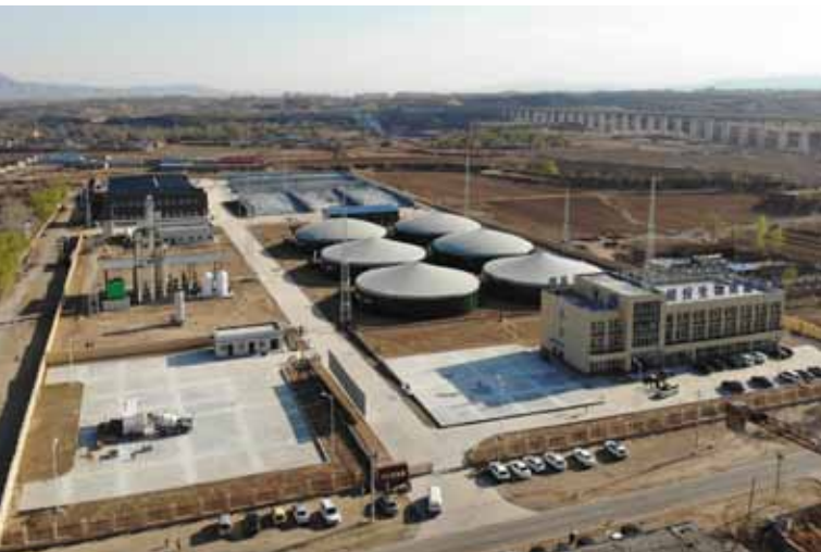
Postrojenje za biogas u provinciji Šanksi dnevno proizvodi 37.680 m 3 biogasa iz energetskih biljnih kultura i sporednih proizvoda životinjskog porekla.
