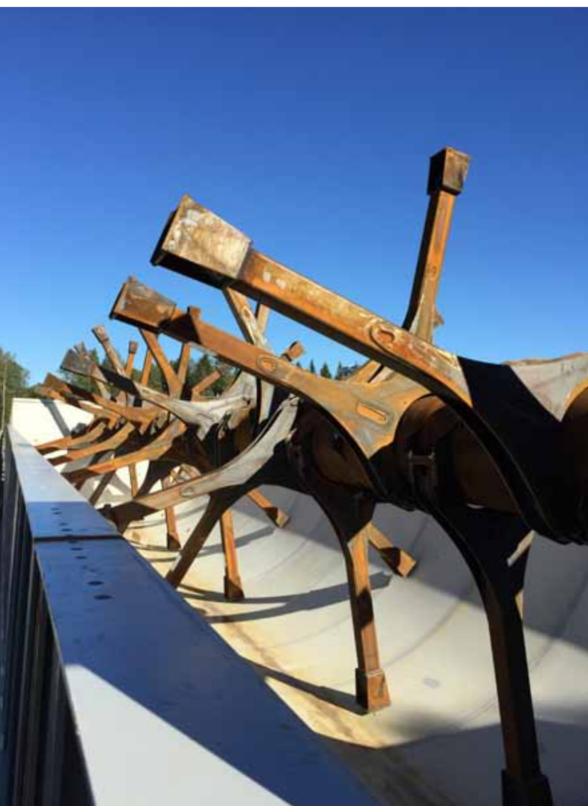
Mešač digestora sa klipnim protokom u izgradnji
