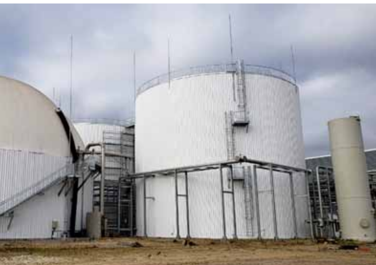
Postrojenje sa rezervoarom za gas, digestorom i sistemom za odsumporavanje
