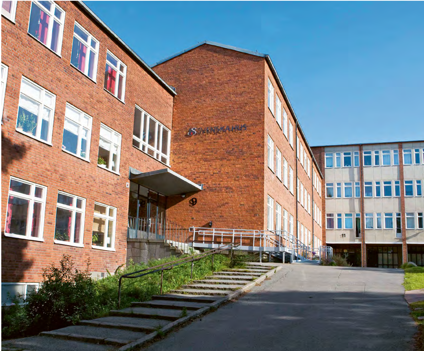
Trollesundsvägen Helt i harmoni med historien och på ett sätt som alltid varit ett signum har Svenska Hus utvecklat Bandhagens Gymnasium i Stockholm. Genom varsam ombyggnation och anpassad nybyggnation har Svenska Hus omvandlat området till bostäder för 160 familjer. Och ännu fler kommer det att bli i framtiden.
