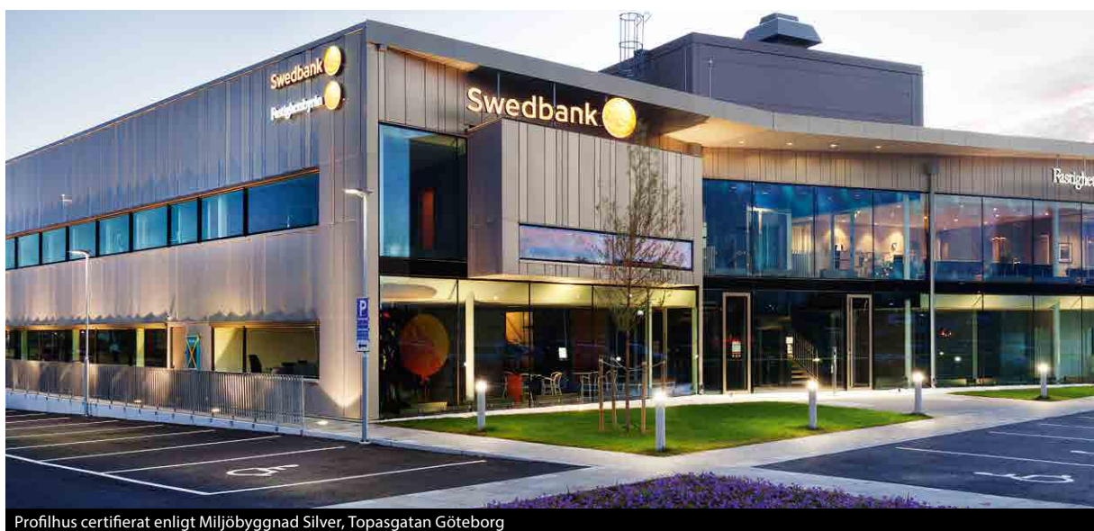
Profilhus certifierat enligt Miljöbyggnad Silver, Topasgatan Göteborg
