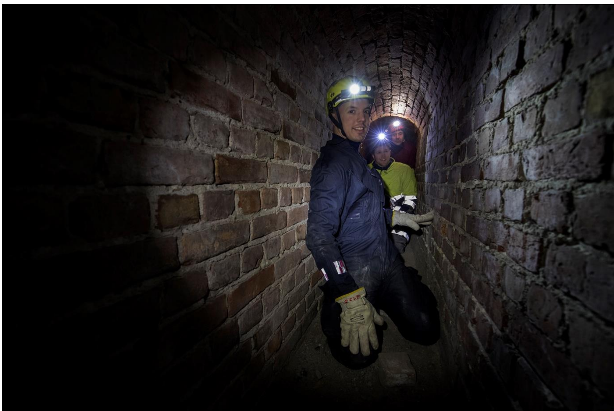
«Inne i tunellen som gjennom Vollen.» Begge foto: Johnny Haglund
