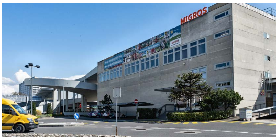
↑ L'entrée de la centrale de distribution de Migros Genève à Carouge.
