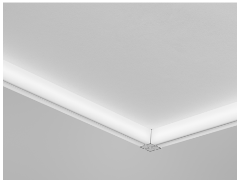
Vault med akustikplatta sett underifrån.
