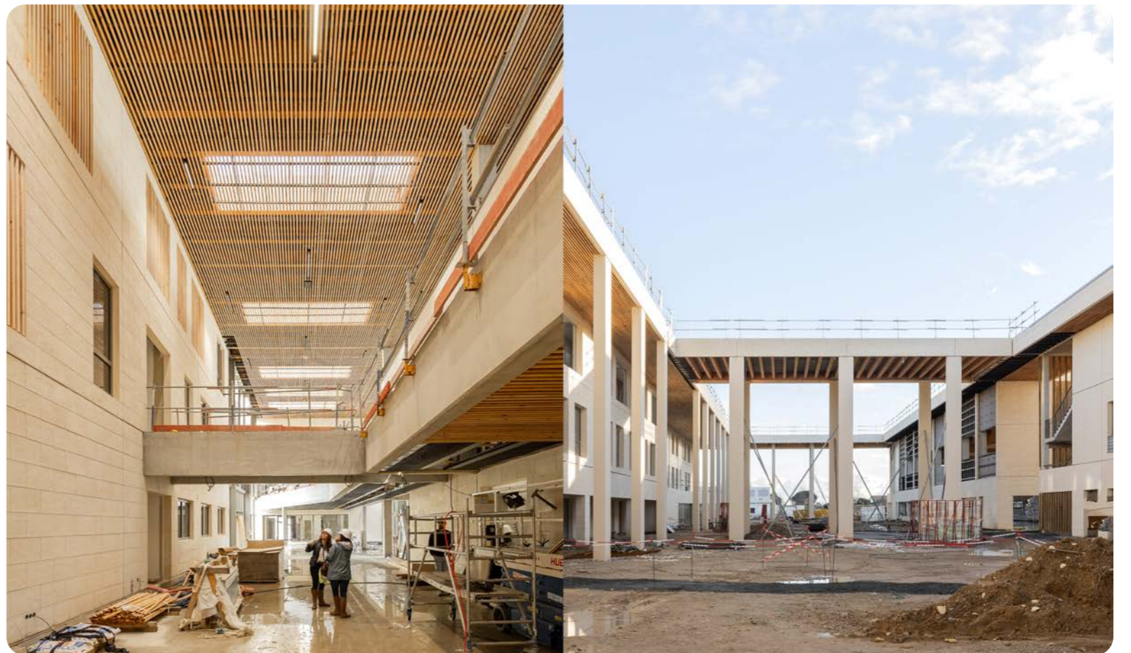
Chantier lycée de Créon (33)
