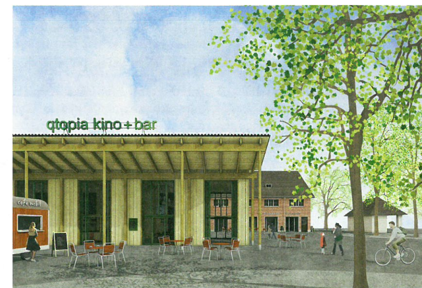
Das Projekt «Alles in Allem» von Adrian Streich Architekten ist an die Typologie der Zeughaus-Hallenbauten angelehnt.
