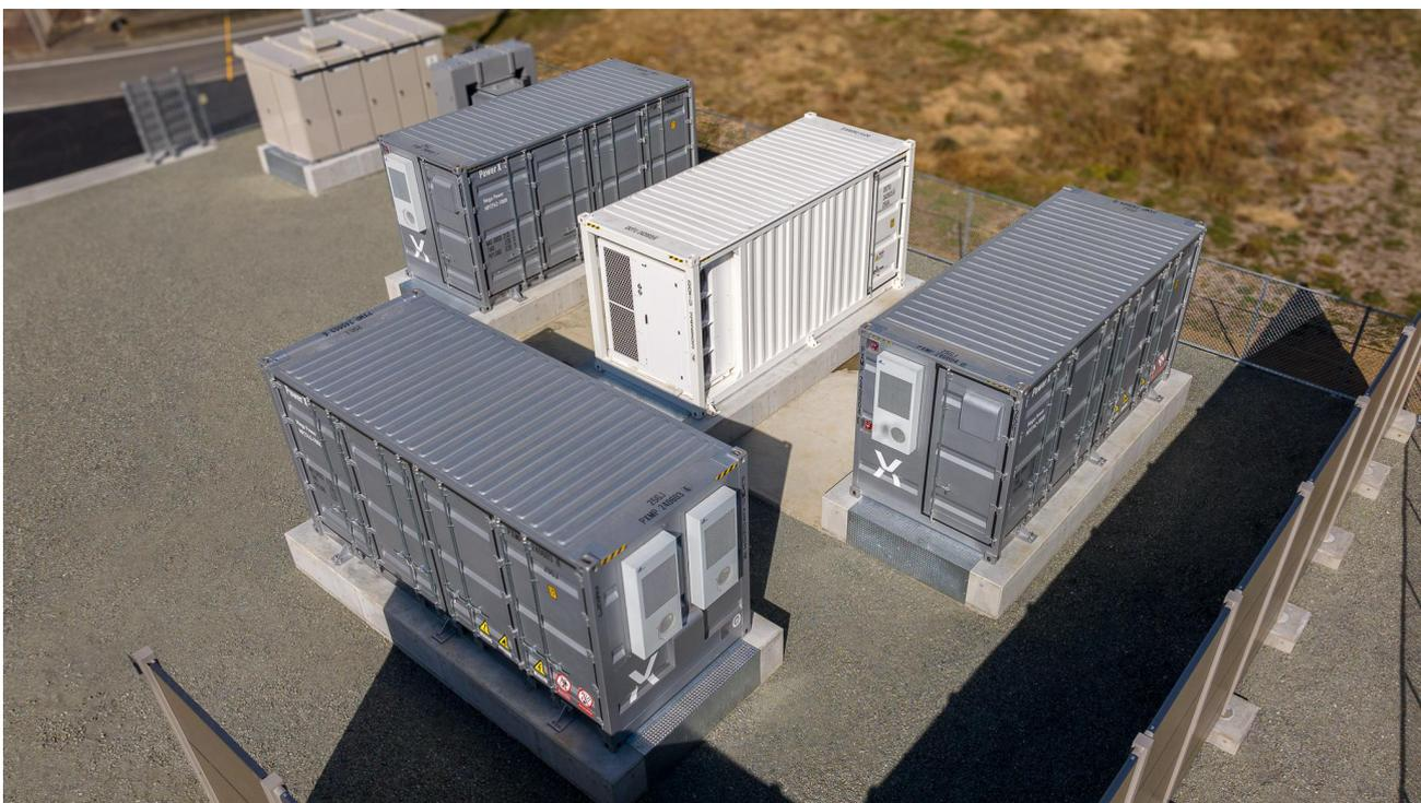
本蓄電所は、電力系統に接続され、電力が余剰となる時間帯には充電を行い、不足時には放電を行うことで、再生可能エネルギーのさらなる導入を支える需給調整の役割を果たします。さらに、本事業は東京都の令和5年度「系統用蓄電池設備導入促進事業」に採択されており、電力需給がひっ迫した際には、都の要請に応じて東京電力管内へ電力を供給します。
