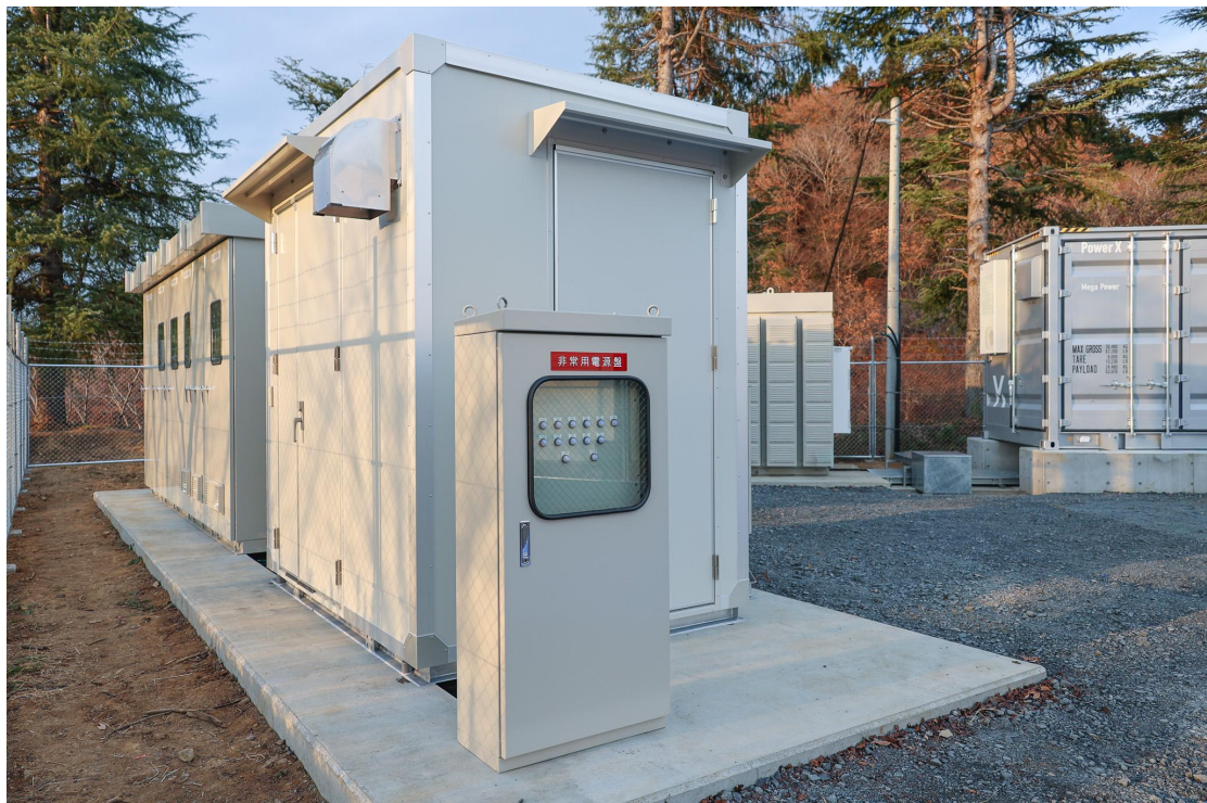
【画像】 災害時に活用できる 100V・200V 対応の非常用電源盤
