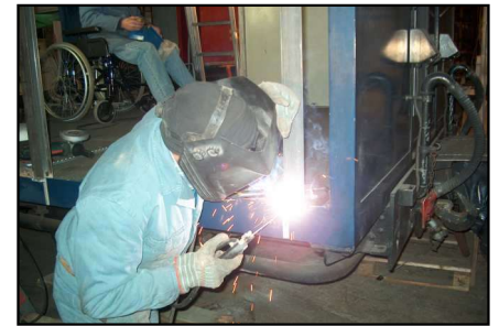
Arbeit an der Einstiegsöffnung
