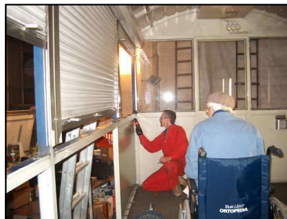
Neue Abdichtung der Seitenwände und weitere Verbesserungen im Zuge des Umbaus
