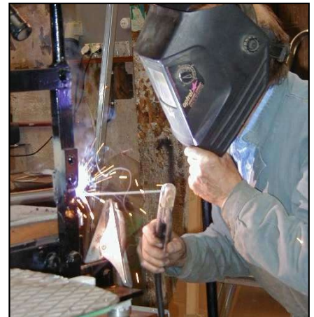
Schweissarbeiten an den Plattformen mit Sicherheitstüren
