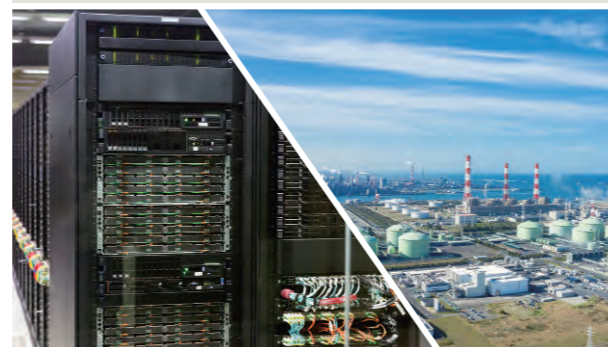
データセンター、エネルギープラント セキュリティエリア入口
