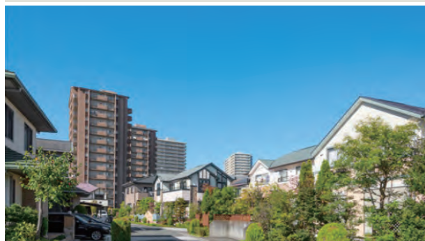
集合住宅、戸建て住宅 専有部・共用部
