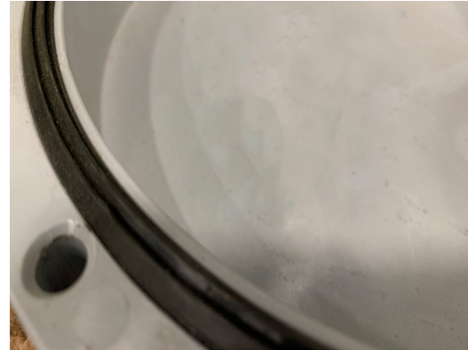
Fig. 12: Condensate Pan Gasket
