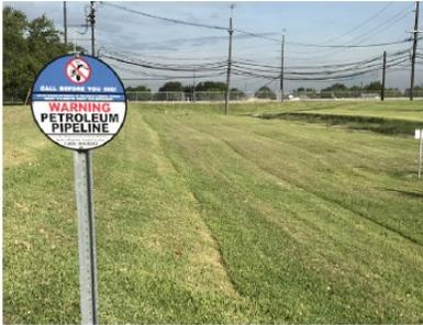
Los marcadores NO indican la ubicación exacta ni la profundidad de la tubería. Esa información puede obtenerse del operador.
