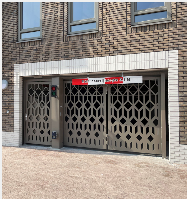
Afbeelding 2: tweevleugelige speedgates en loopdeur.
