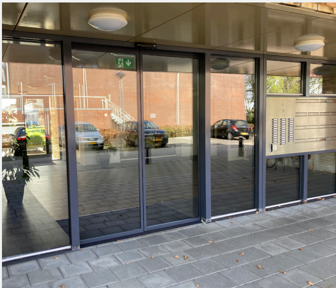
Afbeelding 1. Entree met automatische schuifdeuren
