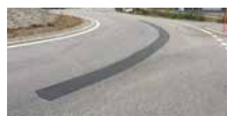
Fessure del manto stradale riparate con Triflex ReproFix RS 2K .
