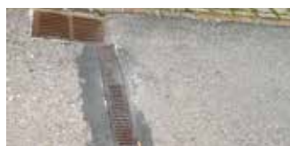
Risanamento sostenibile canalette raccolta acqua...
