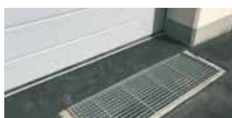
Livellamento ingressi con Triflex ReproFix RS 2K .
