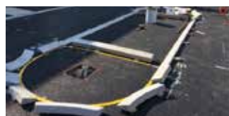
Incollaggio dei cordoli per isole spartitraffico...
