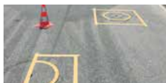
Livellamento dei chiusini...
