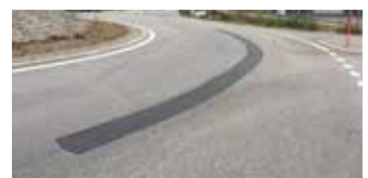
Fissures dans la chaussée réparées avec Triflex ReproFix RS .
