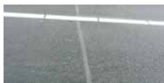
Joints de chaussée remplis de Triflex ReproFix RS 2K .
