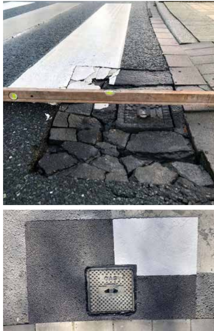
Instandsetzung einer ausgebrochenen Schieberkappe, Kamen
