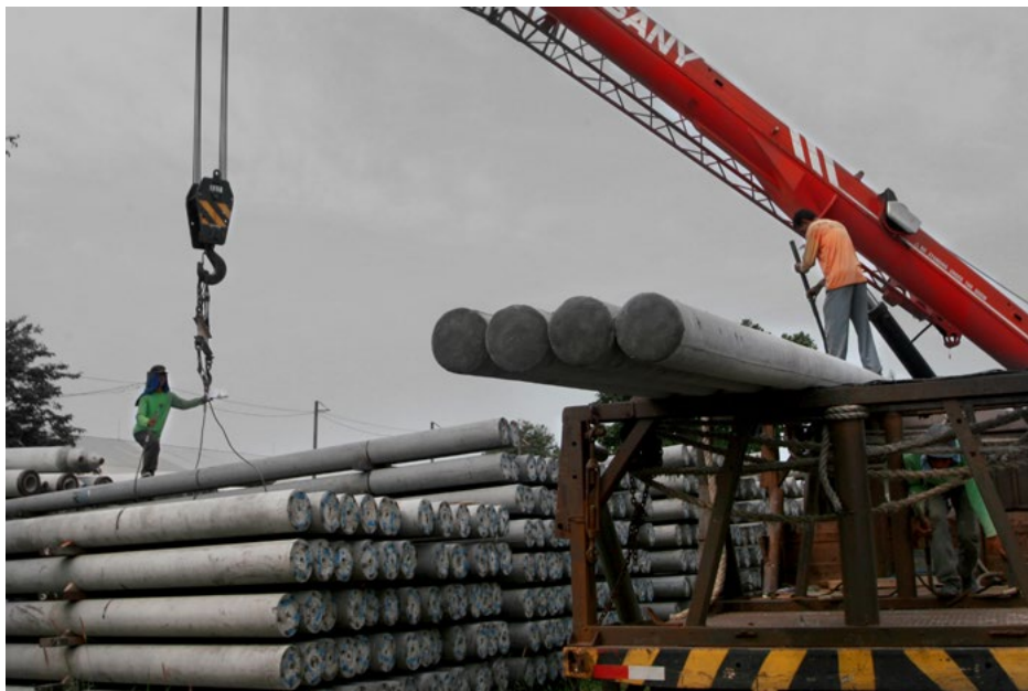
Mengatur muatan tiang pancang diatas truk
