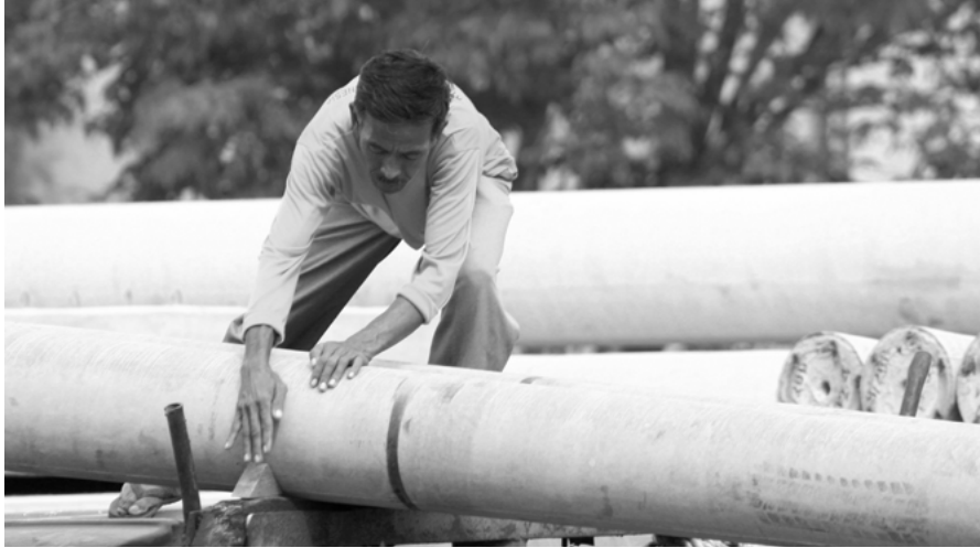
Mengatur tatakan agar tiang pancang aman pada waktu perjalanan
