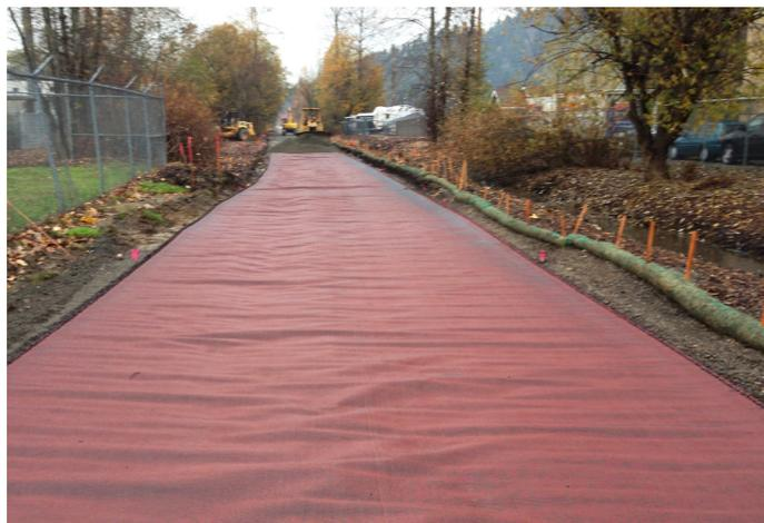
Cette approche a permis de réaliser d'importantes économies de temps et d'argent pour le projet. De plus, le géosynthétique **MIRAFI RS580i** sert de séparateur durable entre les sols saturés à grains fins et la couche d'agrégats propres située au-dessus, assurant ainsi une stabilité à long terme.
