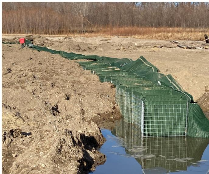
De plus, une section de mur supérieure avec un rang de système **PROPEX** Scourlok a été installée pour protéger l'emplacement actuel des berges.
