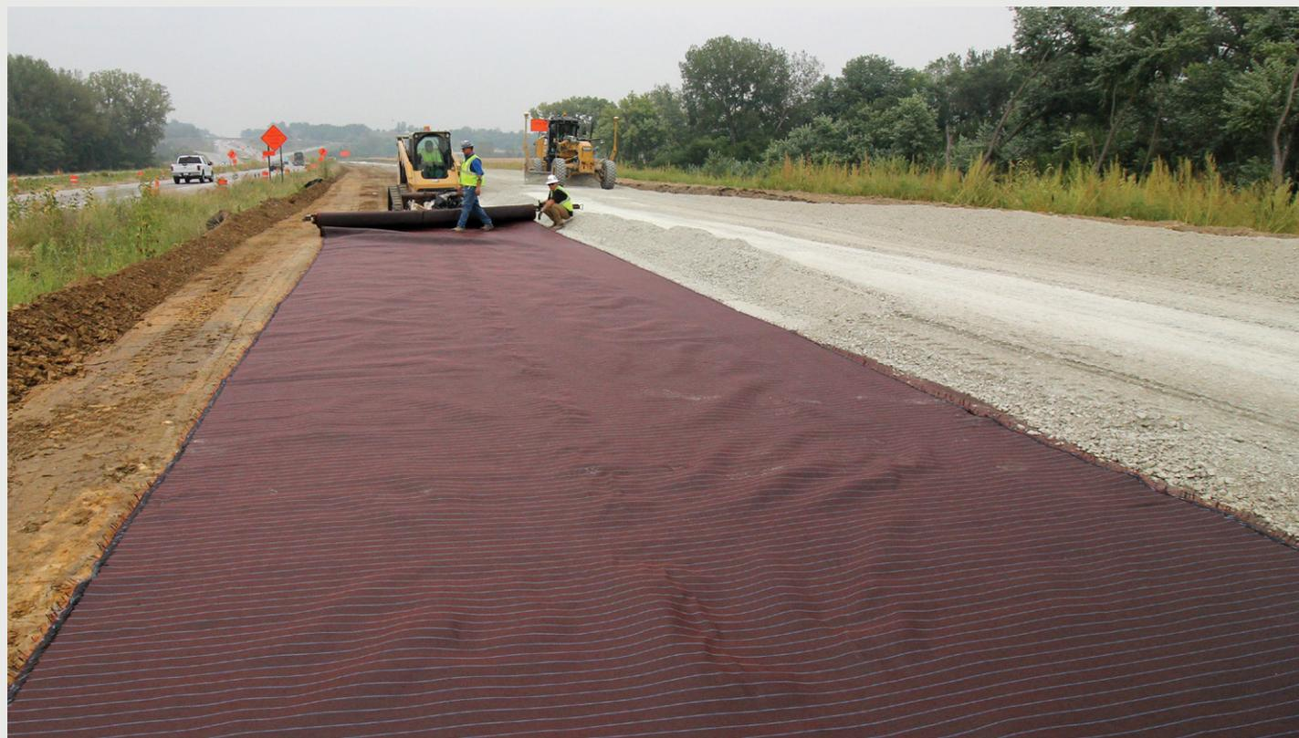
El agua acumulada debajo de las carreteras debilitará la subrasante y provocará daños, incluidos baches y ahuellamiento. El uso de un geosintético con control de la humedad es una forma eficaz de mitigar estos problemas tanto en carreteras pavimentadas como no pavimentadas.
