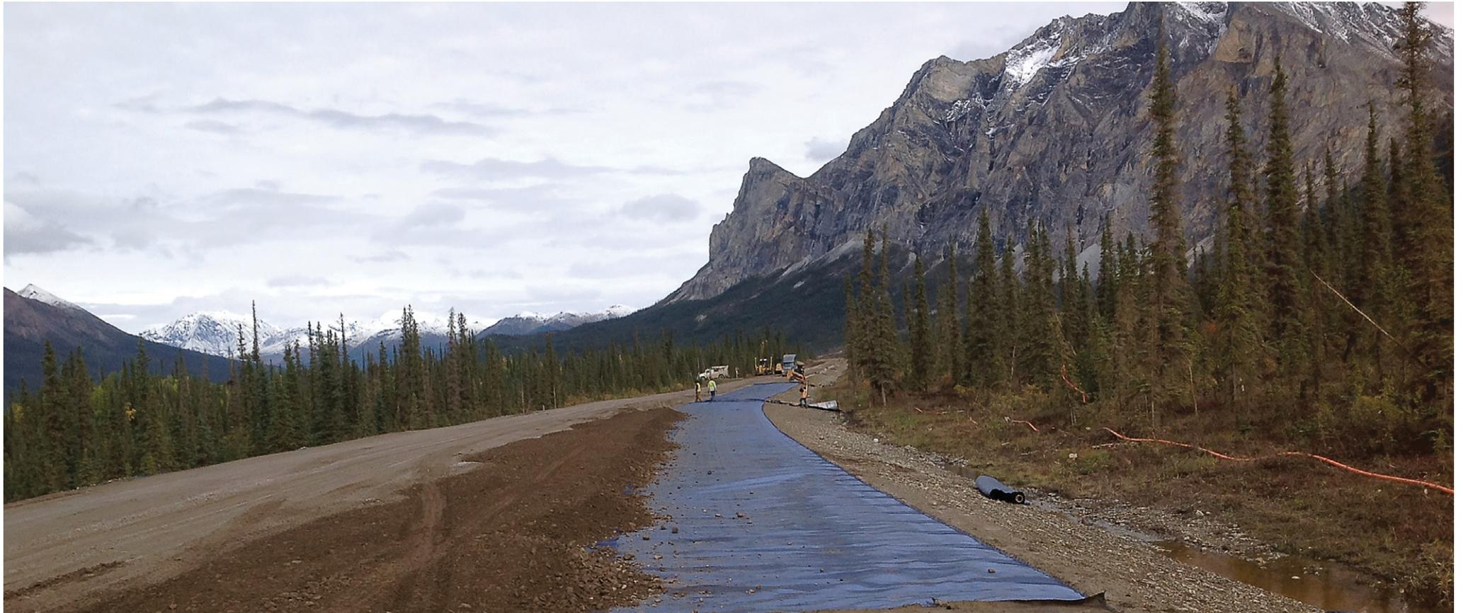
El agua es la mayor amenaza para el rendimiento y la durabilidad de la infraestructura vial. Para mitigar sus efectos dañinos, Solmax ha diseñado las series **MIRAFI**® H<sub>2</sub>Ri y RSi-Series, que ofrecen una gama de soluciones de gestión de la humedad para el refuerzo de la capa base y la estabilización de la subrasante.
