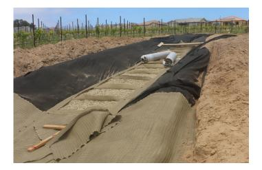
performance **PROPEX** Pyramat<sup>MO</sup> 75 pour construire un composite géosynthétique/sol/roche pour la protection des canaux, des pentes et des déversoirs, a été choisie. Le système combiné a été conçu pour fournir un contrôle de l'érosion sur les pentes latérales et une résistance à l'affouillement dans le fond du canal causé par l'écoulement constant de l'eau.
