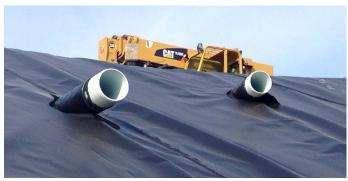
polyéthylène thermoformé par l'intermédiaire de son service de fabrication sur mesure. AEG les a ensuite assemblés et soudés autour de la base de l'aérateur pour former l'enveloppe de protection.
