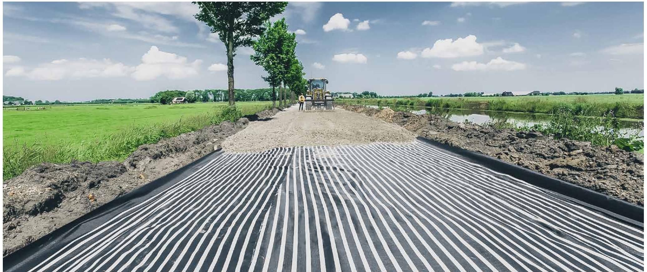
**MIRAFI® HM*i*** ist ein innovatives Geotextil mit extrem hoher Zugfestigkeit bei geringer Dehnung. Es vereinigt mehrere Funktionen in einem Produkt: Bewehren, Trennen und Filtern.
