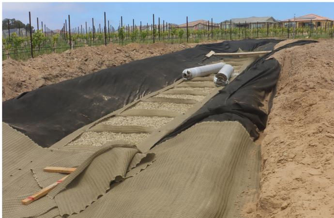
performance **PROPEX Pyramat**<sup>MD</sup> 75 pour construire un composite géosynthétique/sol/roche pour la protection des canaux, des pentes et des déversoirs, a été choisie. Le système combiné a été conçu pour fournir un contrôle de l'érosion sur les pentes latérales et une résistance à l'affouillement dans le fond du canal causé par l'écoulement constant de l'eau.
