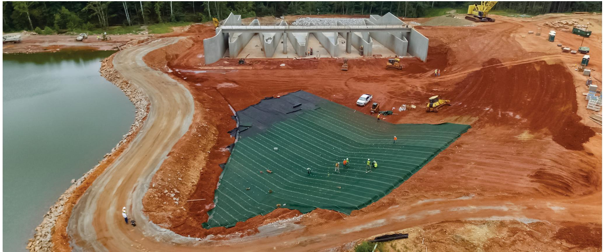
**PROPEX®** Armormax® es la tecnología más avanzada y resiliente para prevenir erosión severa y estabilizar taludes superficialmente.
