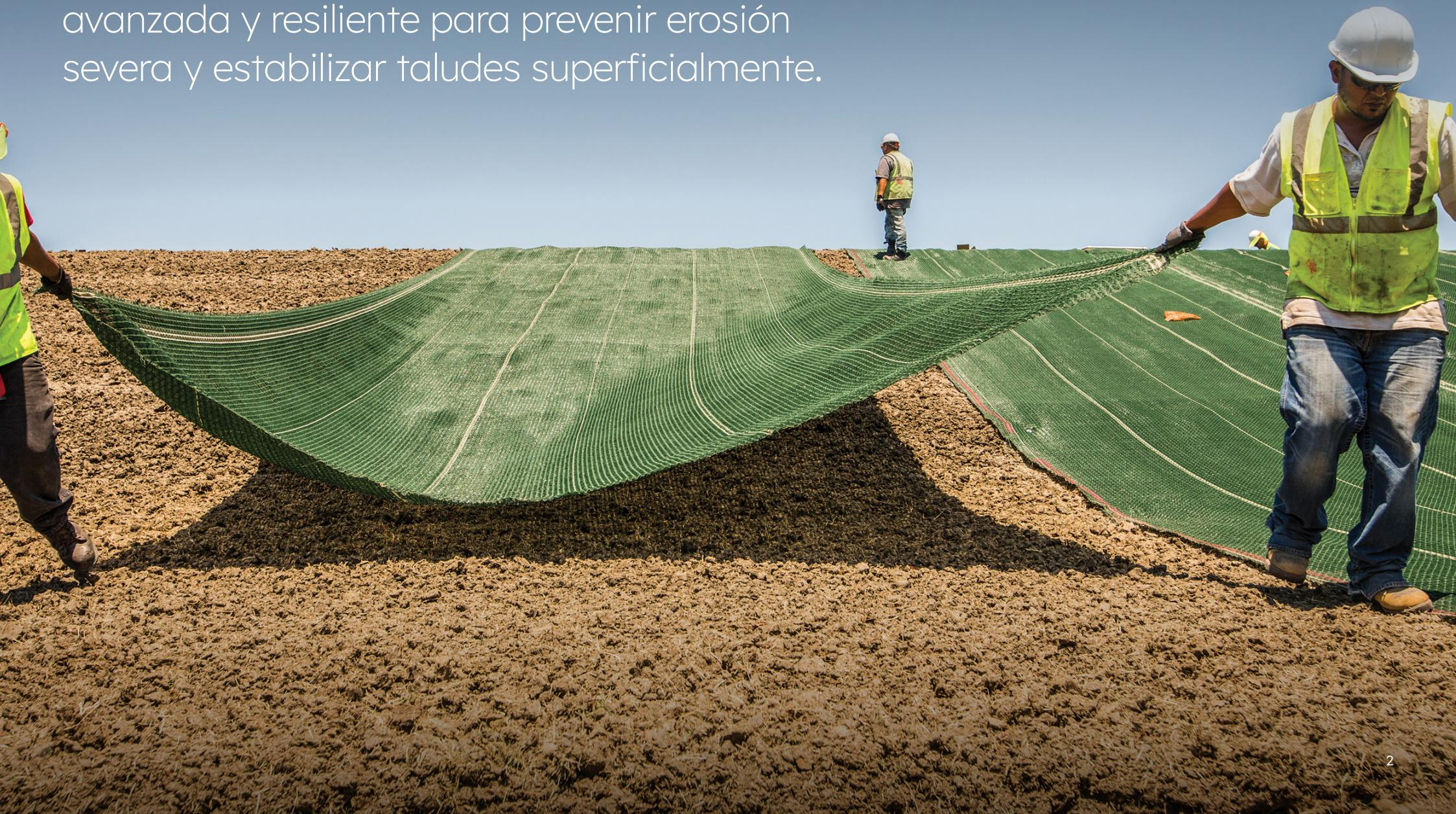
**Armormax de PROPEX está compuesto por un manto de refuerzo de vegetación de alto desempeño (HPTRM, por sus siglas en inglés) y anclas de suelo con ingeniería que trabajan de manera conjunta para mantener el suelo en su lugar y proteger contra los esfuerzos hidráulicos.**
