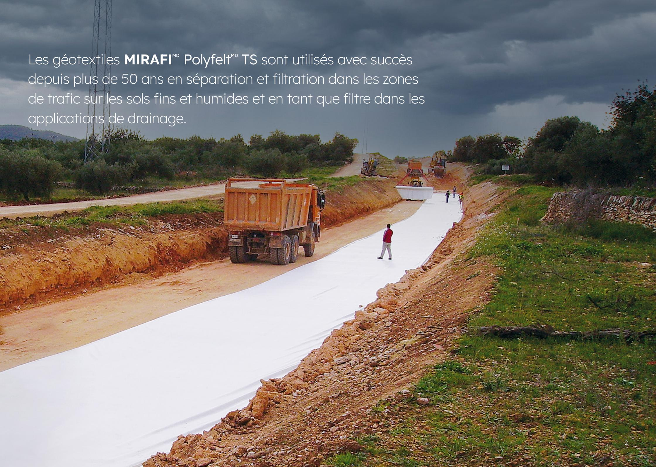
**MIRAFI Polyfelt TS** sont des non-tissés liés mécaniquement d'une masse par unité de surface comprise entre 90 g/m<sup>2</sup> et 400 g/m<sup>2</sup>. Le procédé de fabrication spécial utilisant la technologie des filaments continus et le polypropylène stabilisé aux UV comme matière première offre les avantages suivants :
