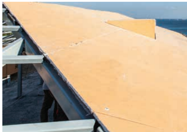
Çatı Kaplama Altı Levhası üstten görünüm
