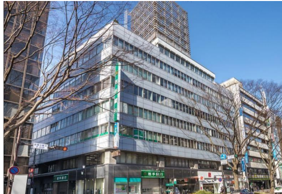
《仙台都会館ビルの外観》
