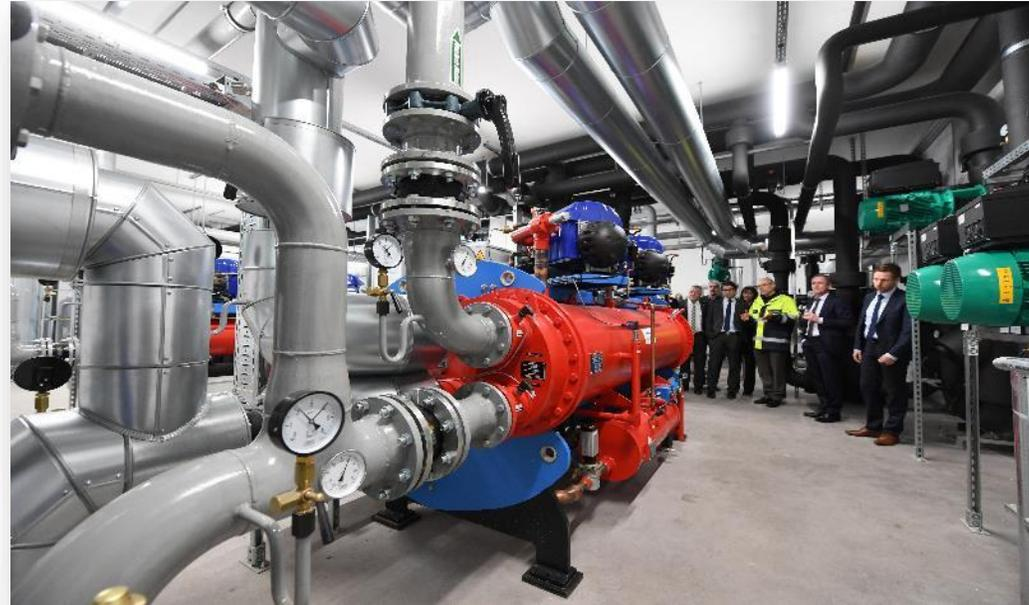
Wärmepumpe 600 kW th
