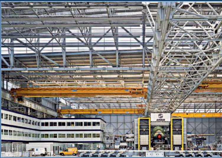
DUCK STRIP RADIANT PANEELIT: AEROSPATIALE TOULOUSE NEW AIRBUS A380 TUOTANTOLAITOS. ASENNUKORKEUS: 40 m
