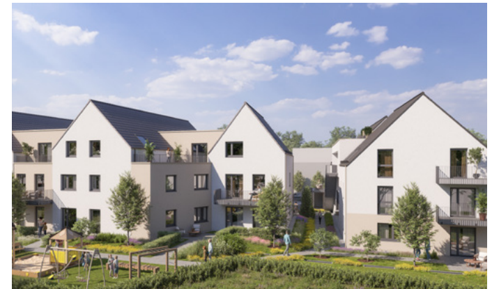
Kirchheim am Neckar Mehrfamilienhaus-Projekt mit 29 Wohneinheiten
