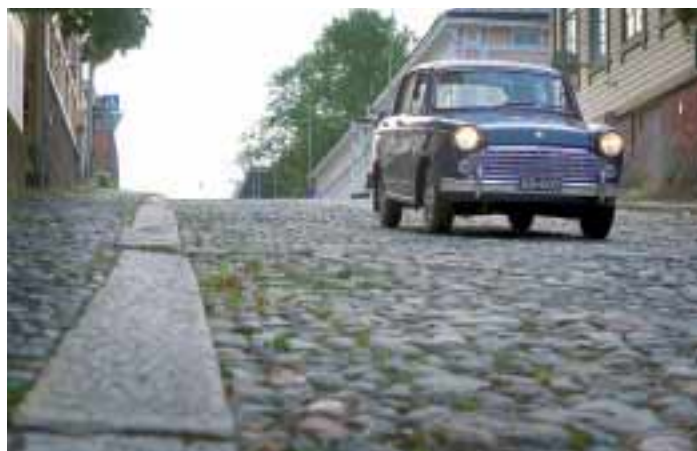
Hämeenlinnassa mukulakivillä päällystetty valtatie kulki kaupungin läpi.
