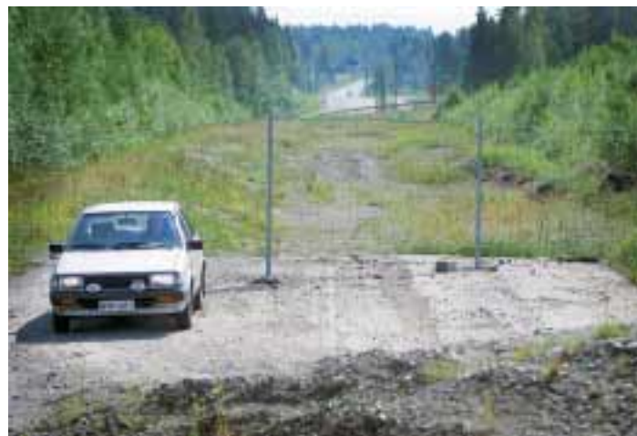
Vanha kolmostie on moottoritien liittymien kohdalla rakennettu osittain uudelleen.
