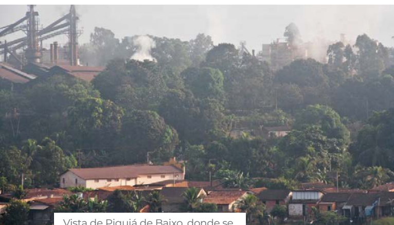
Vista de Piquiá de Baixo, donde se observa lo cercanas que están las casas a la fábrica de acero.
