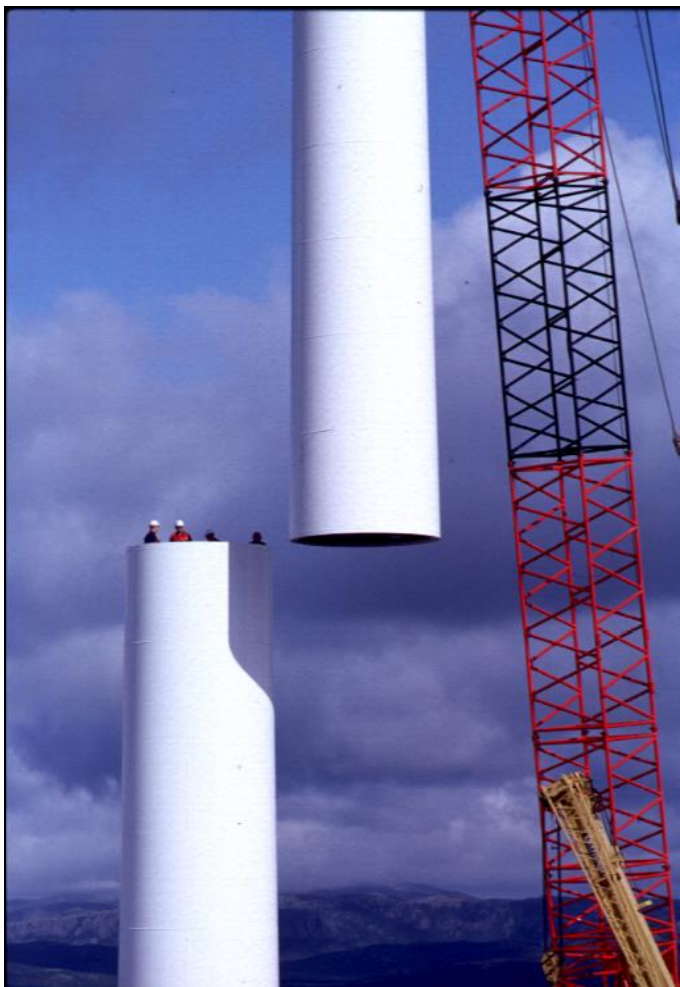
Figur 11 Oppsetting av vindmølle på Tømmerholvfjellet sep. 1998
