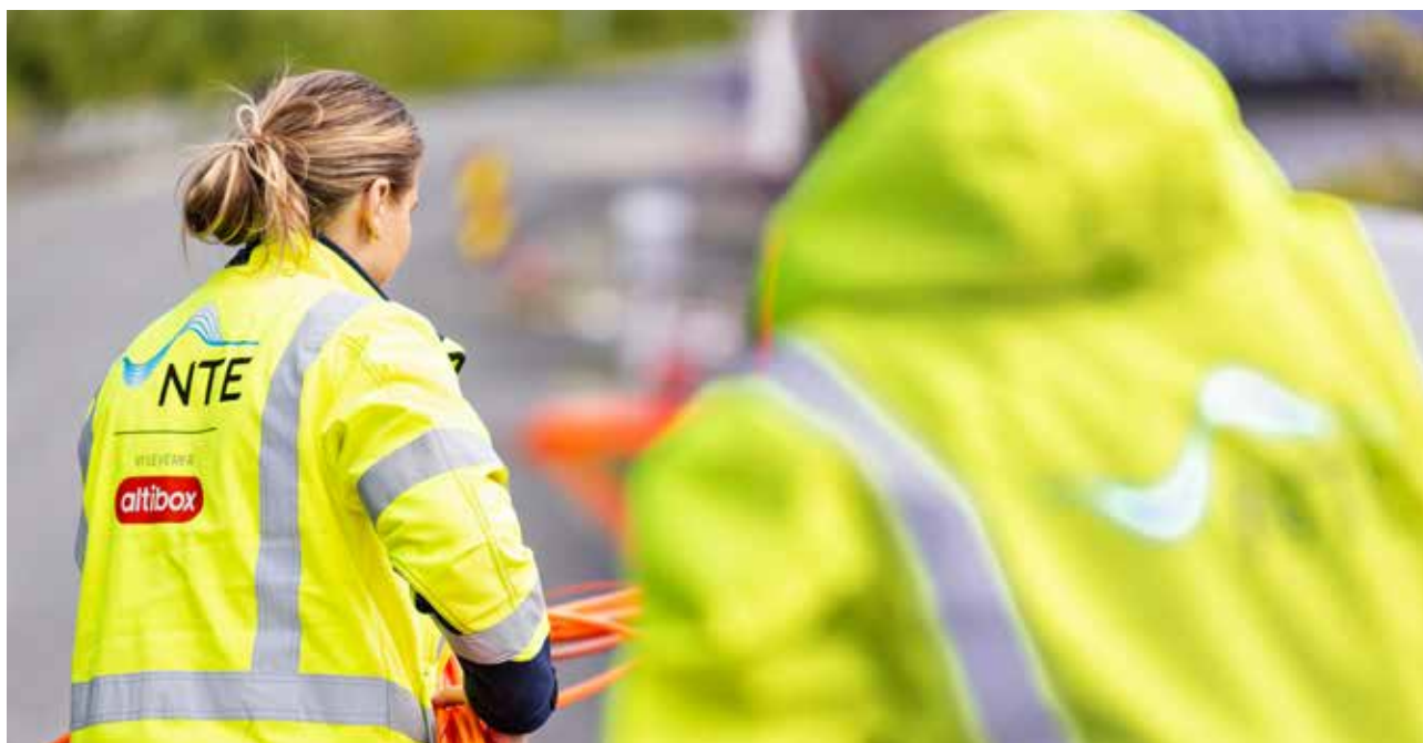
Fiberlegging på Gimse i Melhus
