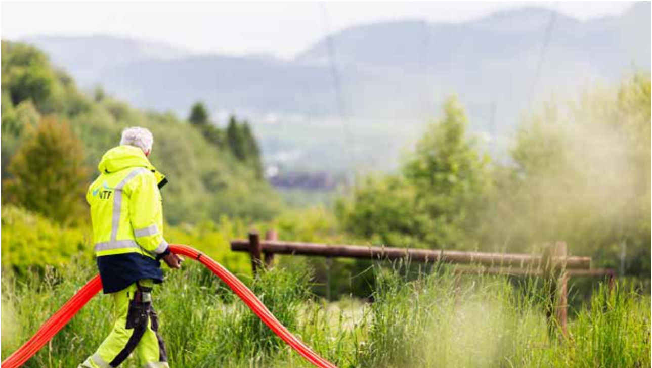
Fiberlegging på Gimse i Melhus
