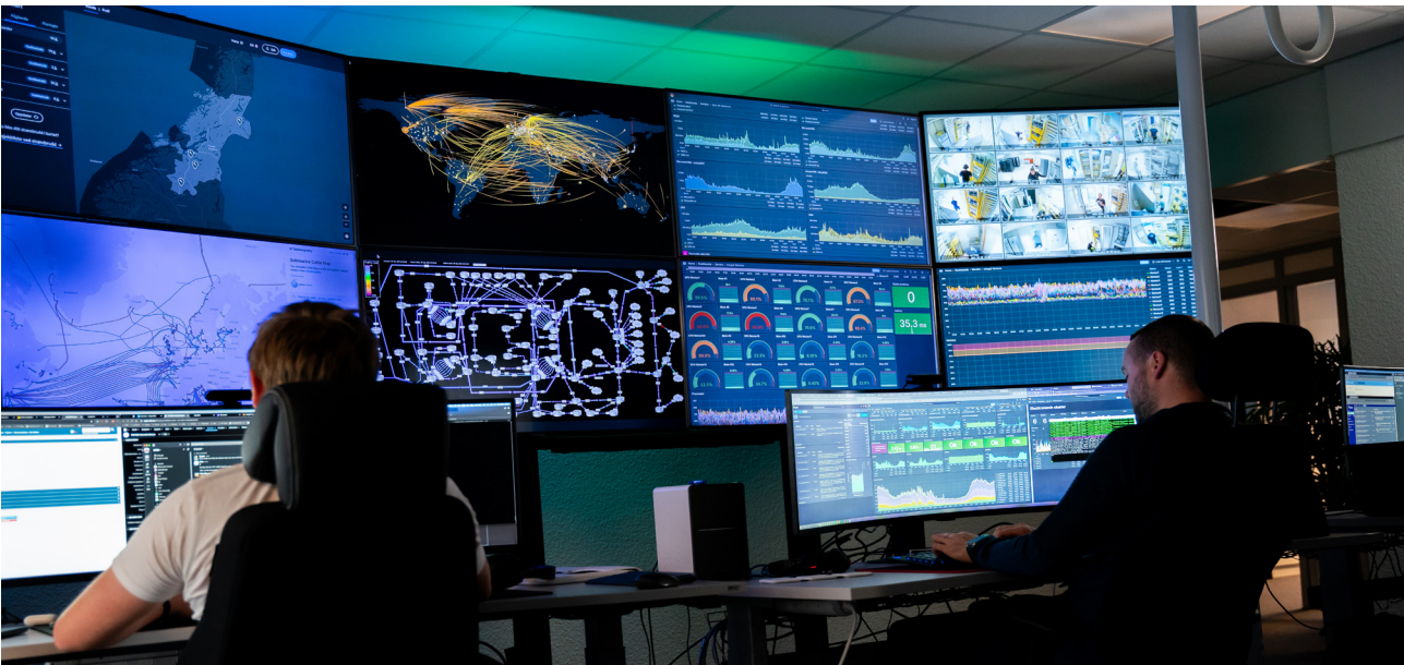
NOC-en hos NTE Telekom sørger for høy oppetid
