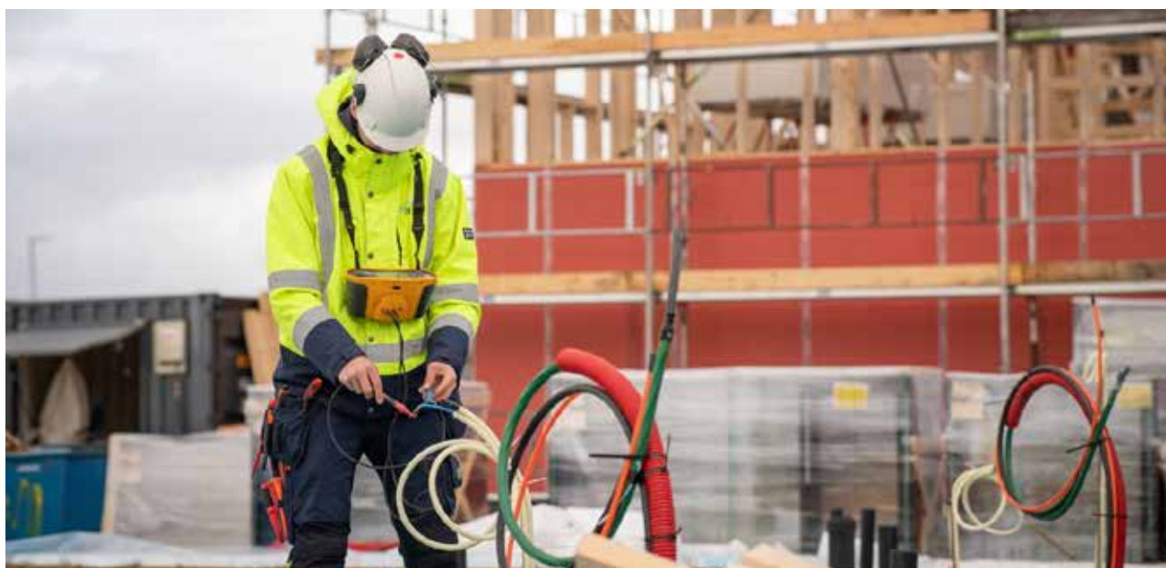
Elektromontør i arbeid
