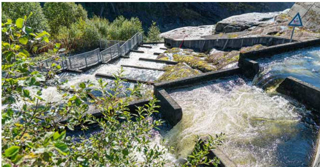
Eksisterende oppvandringsløsning for laks ved Fiskumfoss
