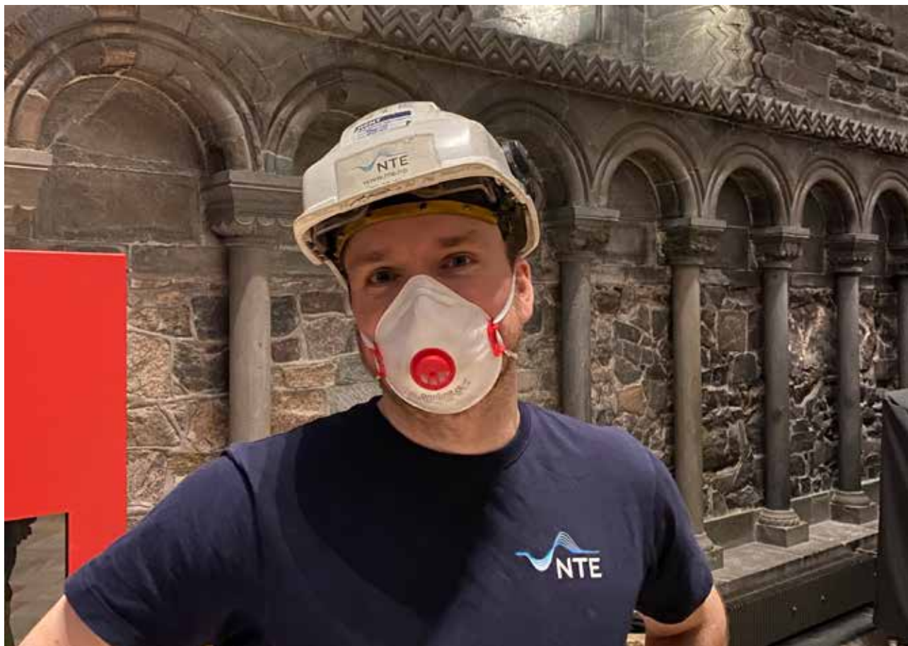
Daniel Olsen, montering av lysanlegg i Nidarosdomen
