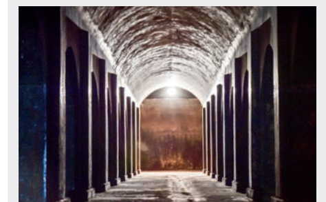
Wasserkammer 1 des stillgelegten Hochbehälters Kannonenweg Foto: Ferdinando Iannone©
